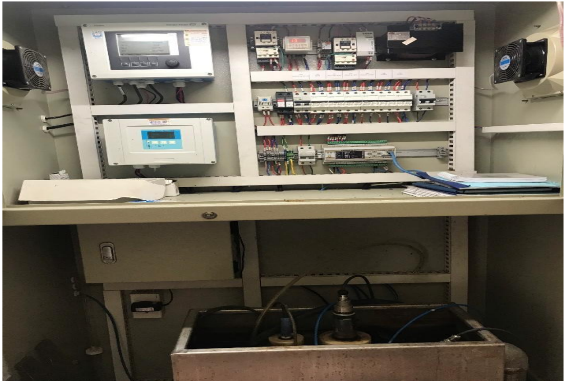
Hình 3.14 Tủ quan trắc tự động
