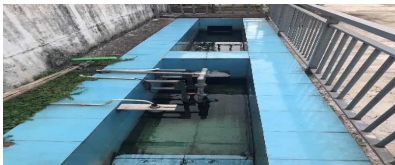
Hình 3.12 Mương quan trắc tự động
