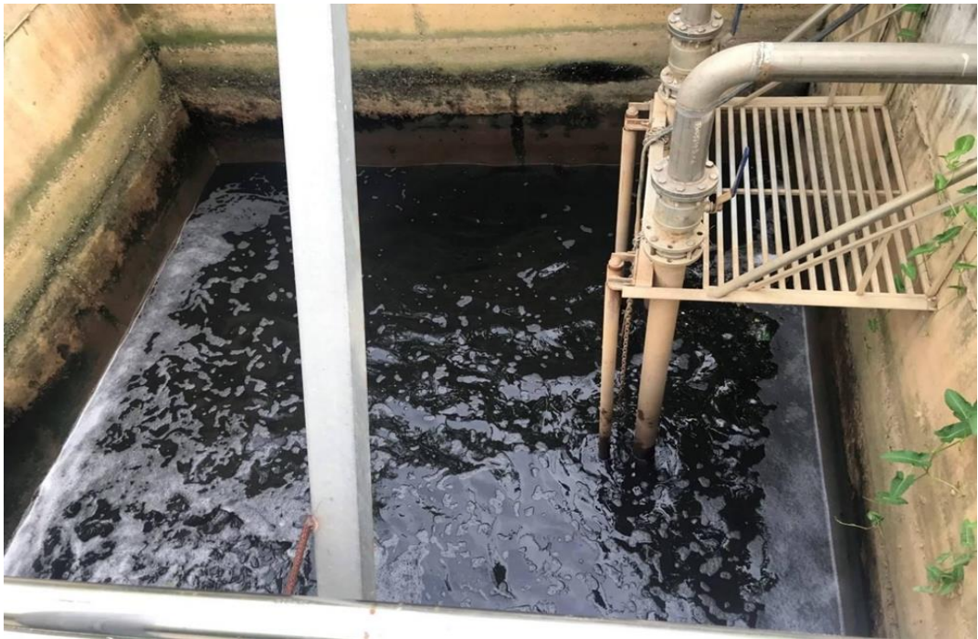
Hình 3.5 Bể thu gom nước thải
